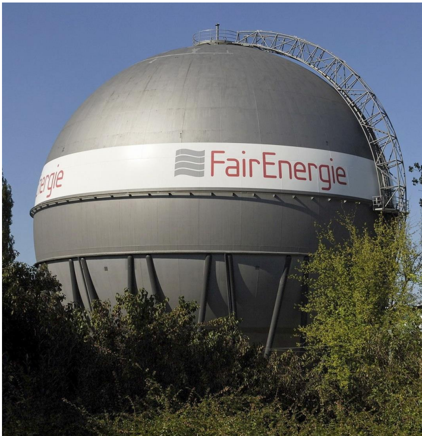
Mit einer Speicherkapazität von ca. 1 GWh dient die Gaskugel von FairNetz als „netzdienlicher Speicher“ und hat keinerlei Bedeutung als saisonaler Speicher. Quelle: FairEnergie GmbH.
